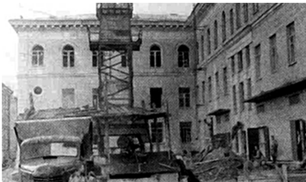
Завершение строительства здания ВЦ № 1 на Хорошевском проезде, 1955 год (см. также цветную вклейку)
