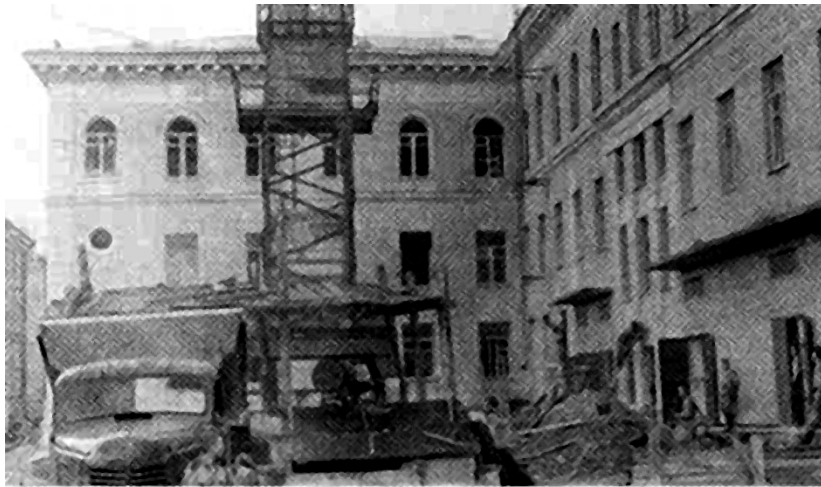
Завершение строительства здания ВЦ №1 (1955 г.)
