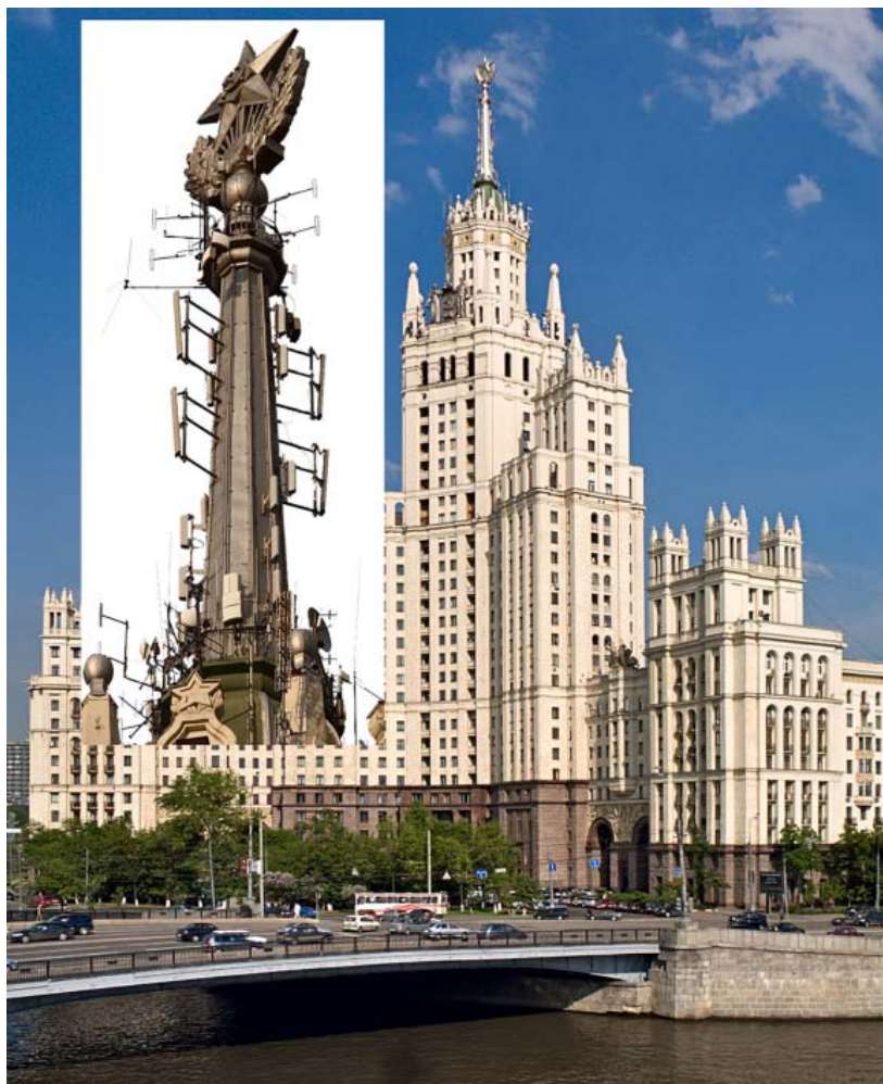
Антенны системы «Алтай» на шпиле дома на Котельнической набережной, г. Москва
