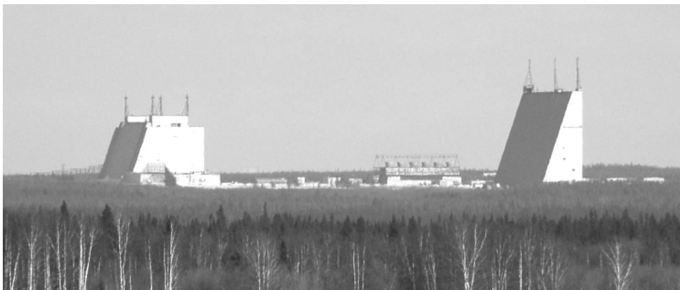
Одна из радиолокационных станций «Дарьял» (Печора). Слева — излучающая часть, справа — приемная. Работает в системе СПРН по настоящее время. В марте 2014 года было объявлено, что станция к 2016 году пройдет глубокую модернизацию без снятия с боевого дежурства
