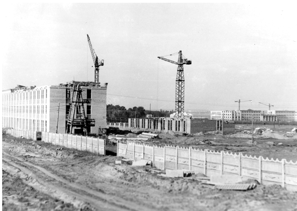
Строительство первых корпусов КЗММ. 1957 год
